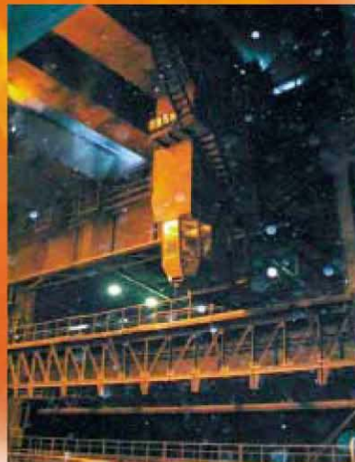
La grúa de fundición de 200 toneladas a la luz del arrabio fundido.
