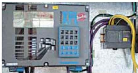
AiRanger XPL Plus. Este es el equipo Milltronics utilizado en el proyecto. El AiRanger procesa la información de los sensores XPS-40 y la envía al S7-400 a través de Profibus-DP
