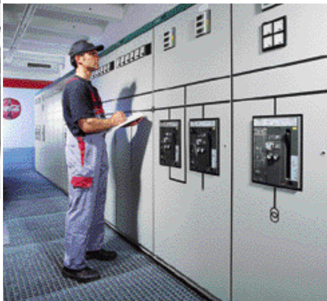
Interruptores automáticos de potencia 3WN6 en el tablero de baja tensión.
